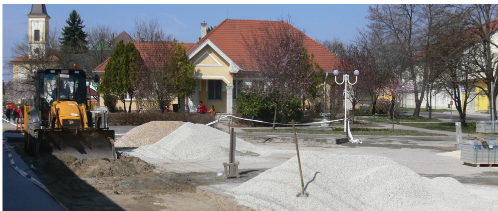
Díszter épül: márciusban kezdődött és áprilisban be is fejeződik a Kossuth tér felújítása. Fotó: Tilai Zoltán
